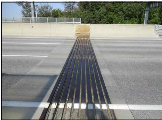
신축이음 상부 전경(A2)
