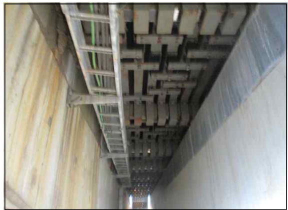
신축이음 하부 전경(A2)
