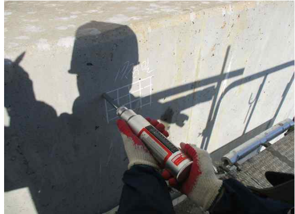
교각 압축강도 측정
