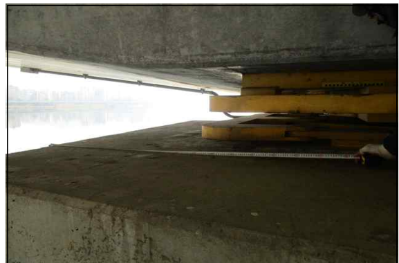
교량받침 연단거리 측정 현황②
