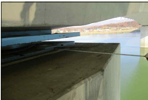
교량받침 연단거리 측정 현황①
