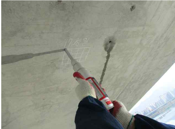
거더외부 압축강도 측정
