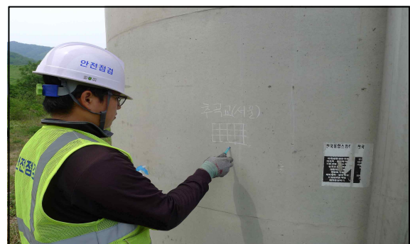
천공부 분진 제거(교각)
