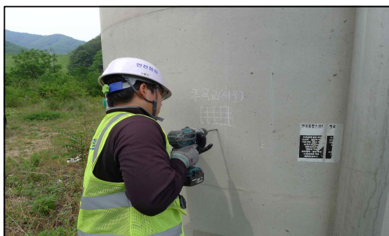
탄산화시험을 위한 부재 천공(교각)
