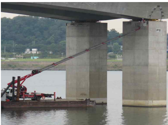
바지선 및 작업차량을 이용한 외관조사①
